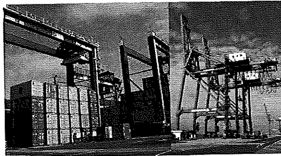
コンテナヤードおよびコンテナバース
