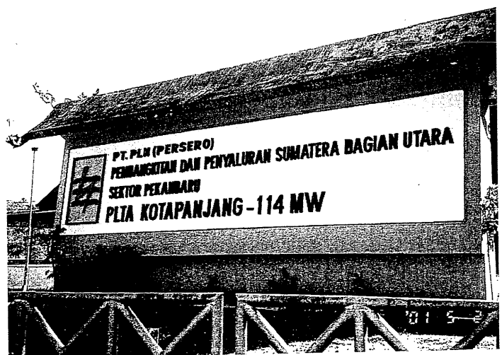
17メガワットしか発電していない発電所(発電能力は114メガワット)
