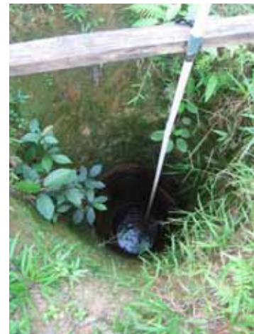
(写真 3-2 写真 3-1 の中を覗き込んだ状況)
