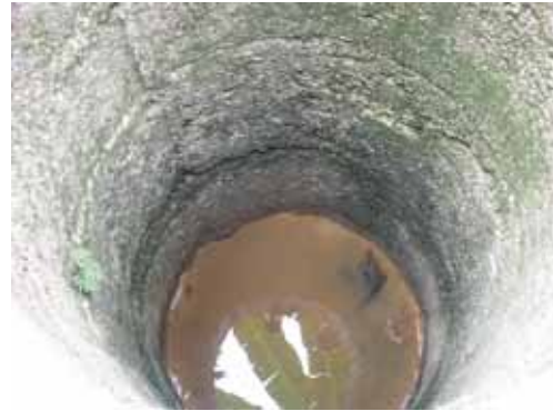
（写真 6-2 写真 6-1 の中を覗き込んだ様子）
