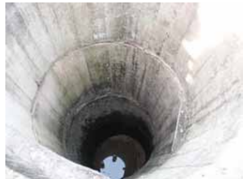
(写真 8-2 写真 8-1 の井戸を覗き込んだ様子 - 底に土が見え、涸れていることが判る)
