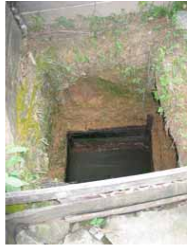
(写真 2-2 写真 2-1 の中を覗き込んだ状況)
